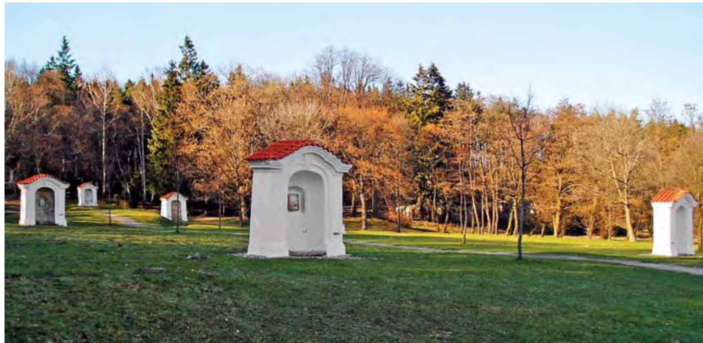
Poutní místo Skalka, kapličky – křížová cesta z let 1756–1762 vedoucí od kláštera ke kostelíku sv. Maří Magdalény, který byl v letech 1692–1693 vybudován stavitelem Kryštofem Dientzenhoferem na ostrohu nad městečkem.
